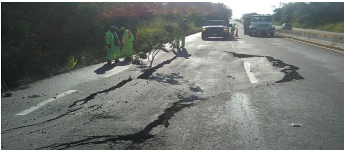
**Figura 2.47. Daños diversos se registraron en los caminos federales y estatales de Tabasco, desde simples inundaciones hasta agrietamientos y desgajamientos de la superficie de rodamiento.**
