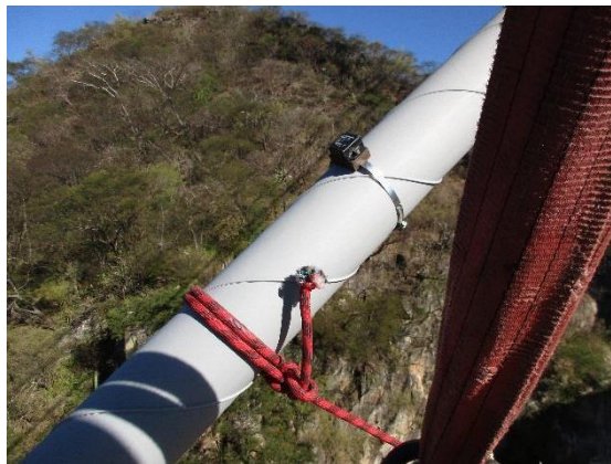
Figura 3.5 Acelerómetro colocado en un tirante
