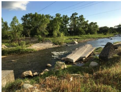
Figura 4 Aguas arriba del puente
