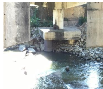
Figura 8 Socavación
