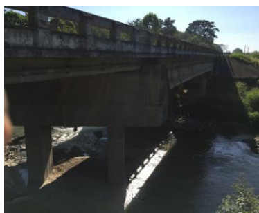
Figura 10 Vista del puente
