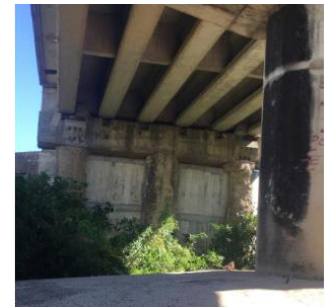
Figura 28 Puente Urbina cuerpo 2
