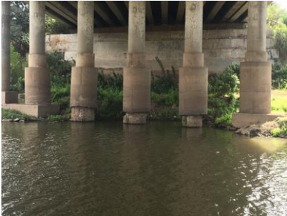
Figura 89 Socavación
