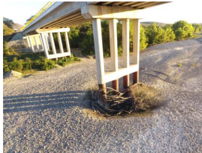
Figura 65 Socavación local
