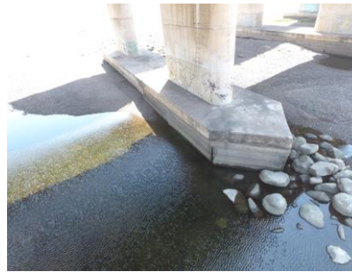
Figura 85 Socavación
