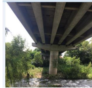
Figura 29 Puente Urbina cuerpo 1
