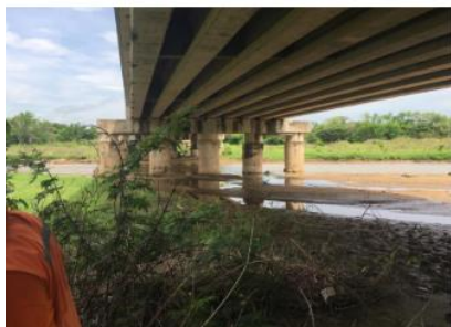
Figura 19 Vista de puente
