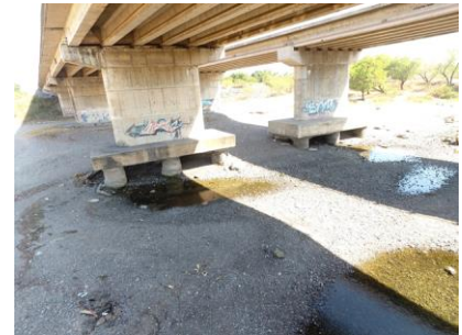
Figura 84 Socavación
