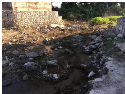
Figura 39 Socavación general
