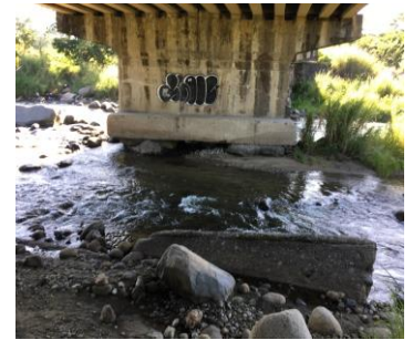
Figura 14 Zapata socavada
