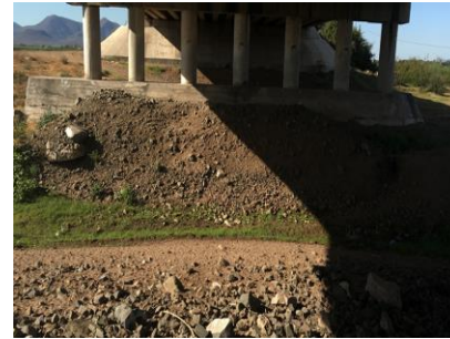
Figura 60 Socavación general
