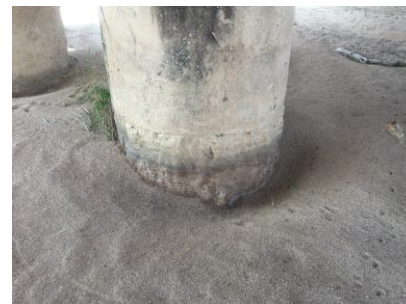
Figura 20 Socavación
