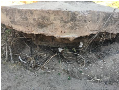
Figura 68 Socavación
