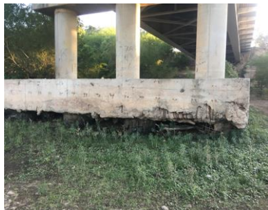
Figura 33 Socavación
