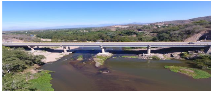
Figura 80 Vista de puente
