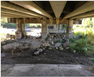
Figura 13 Vista debajo del puente
