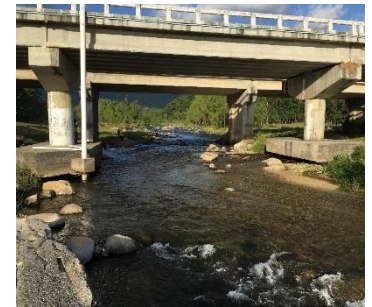
Figura 5 Vista frontal del puente
