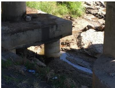
Figura 9 Socavación local
