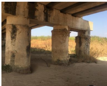
Figura 18 Socavación
