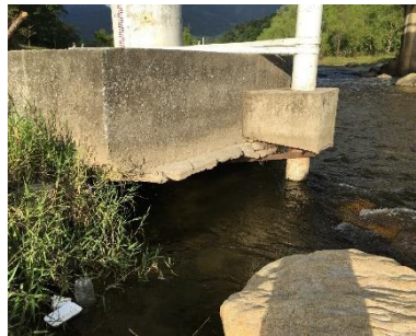
Figura 3 Socavación
