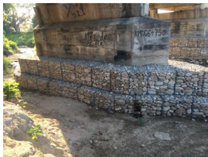
Figura 38 RipRap en pila de puente
