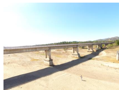
Figura 48 Vista de puente
