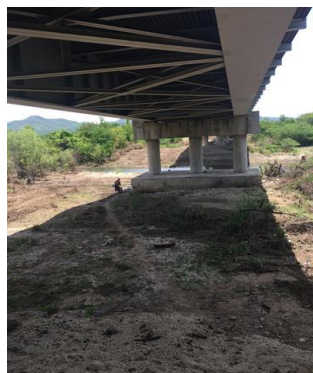
Puente Pijijiapan C2
