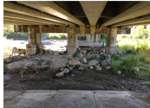
Superestructura y pila puente novillero
