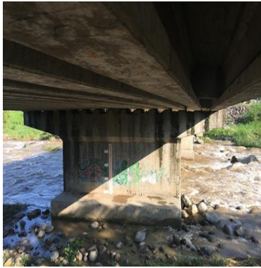
Pila central puente novillero
