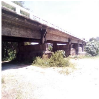
Puente San Francisco
