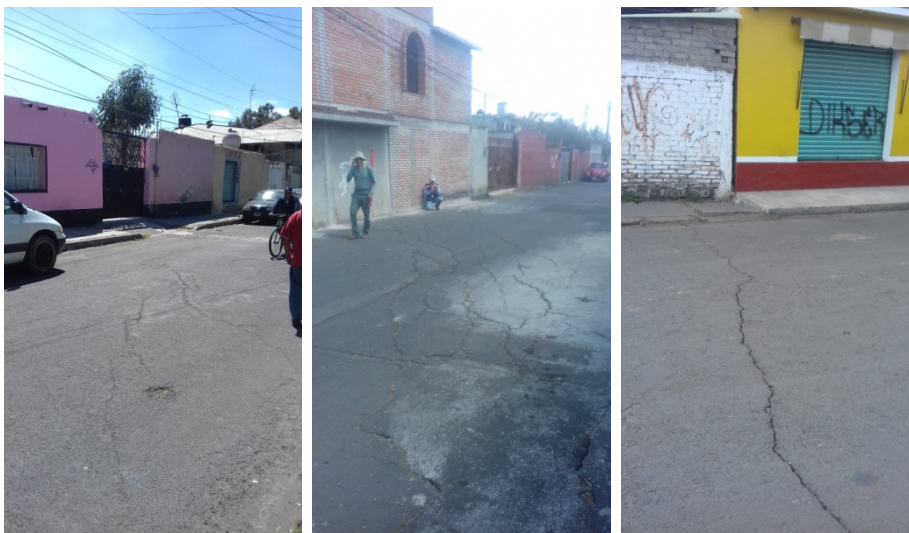
Figura 8. Ejemplos de diversas geometrías del fracturamiento en diversos sitios de la Delegación Tlahuac.
