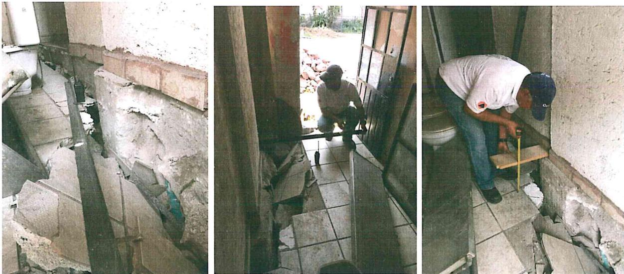
*Figura 13 Daños registrados en las instalaciones del hotel ExHacienda de Xaltocan, debidas al hundimiento súbito sucedido durante el evento telúrico del 19 de septiembre de 2017*
