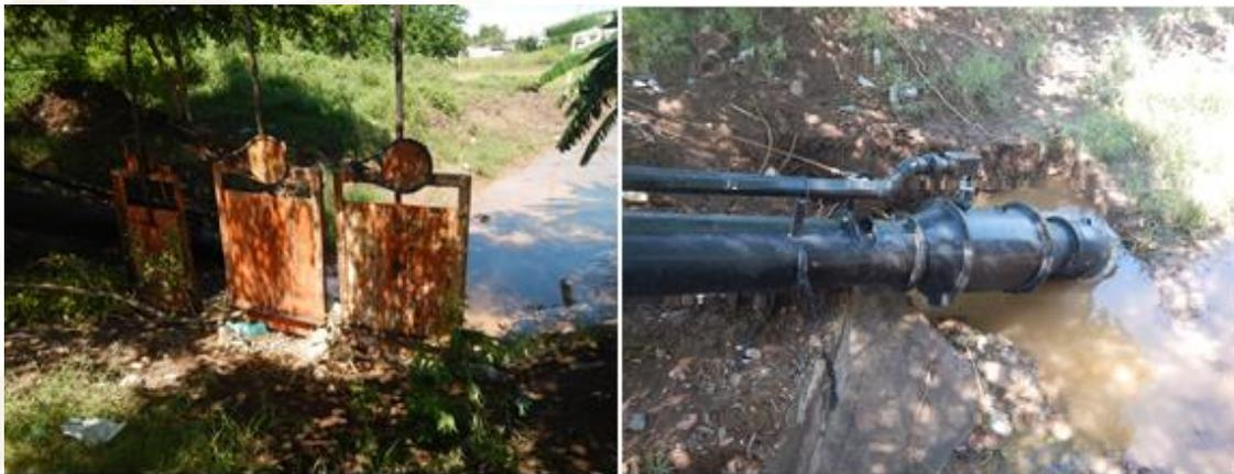
*Figura 34. Compuertas y bombas para conducir escurrimientos superficiales de la colonia Las Garzas hacia el dren dique Aeropuerto, ciudad de Guamúchil*
