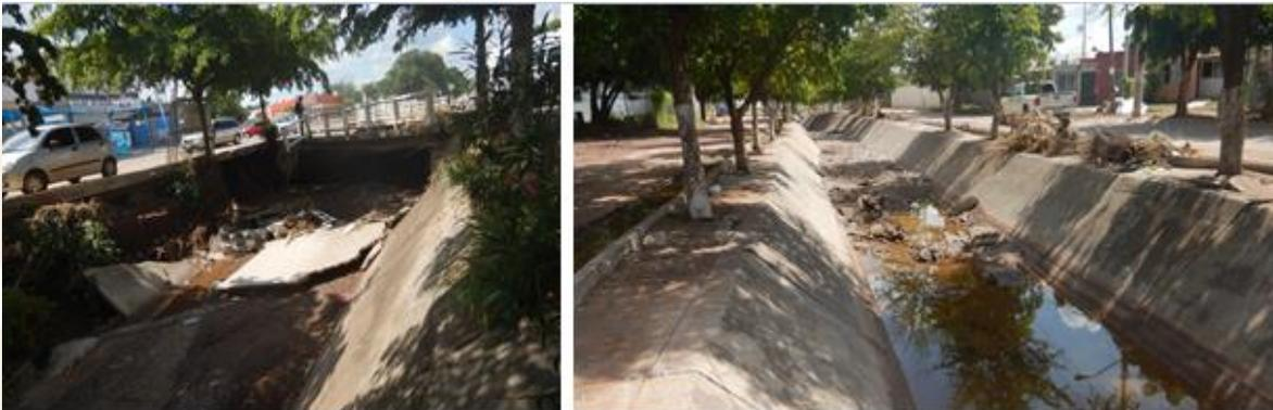
*Figura 17. Afectaciones y azolve en el canal pluvial de la colonia Santa Fe, ciudad de Culiacán*
