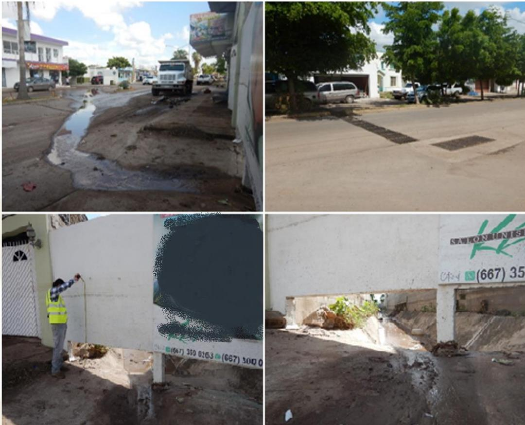
*Figura 4. Escurremientos pluviales que se dirigen hacia un canal trapezoidal, la obstrucción de éste provocó un incremento en el tirante en boulevard Valle Alto, ciudad de Culiacán*
