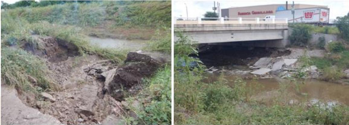
*Figura 10. Erosión en las márgenes del dren y bajo el puente vehicular del boulevard Valle Alto y el dren Bacurimi, ciudad de Culiacán*
