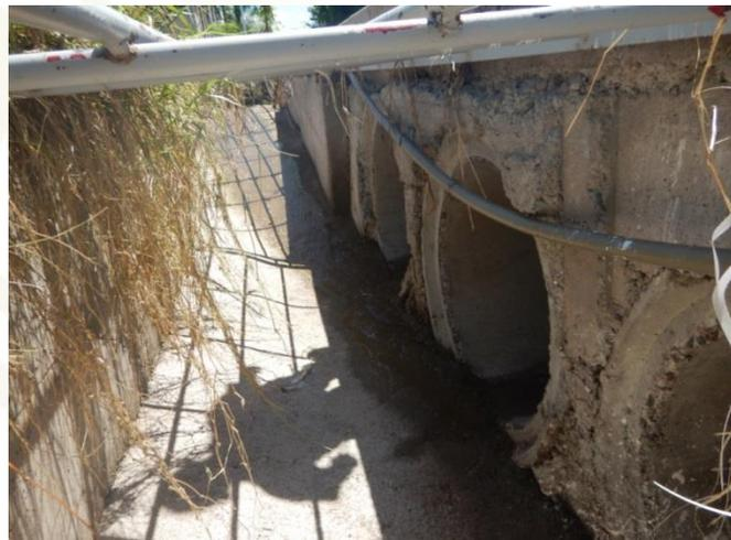
*Figura 26. Rejillas pluviales y conducción mediante tres tuberías de 1 m de diámetro ubicadas en la zona baja de la ciudad de Guamúchil*
