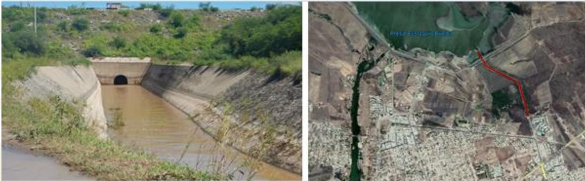
*Figura 25. Sección y recorrido del canal de la obra de toma de la presa Eustaquio Buelna, ciudad de Guamúchil*
