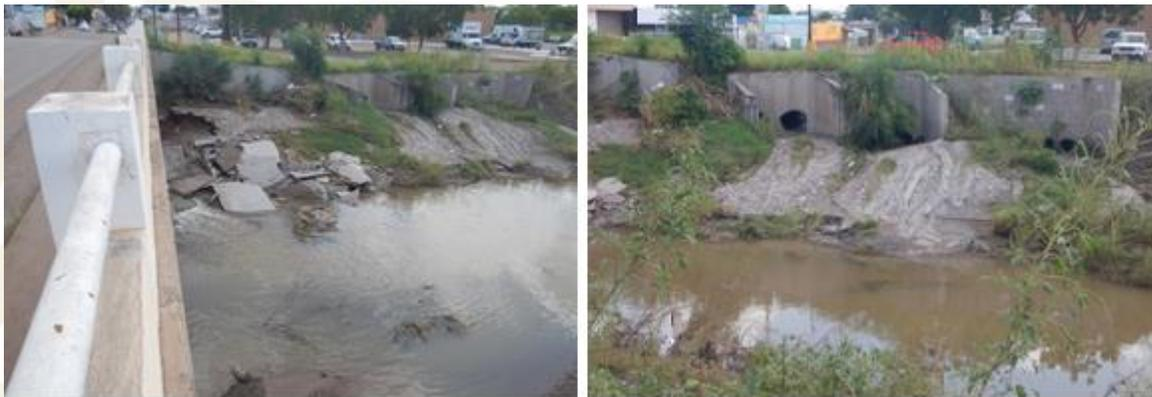
*Figura 11. Afectaciones en el puente vehicular y descargas de la colonia Villas del río Elite, ciudad de Culiacán*
