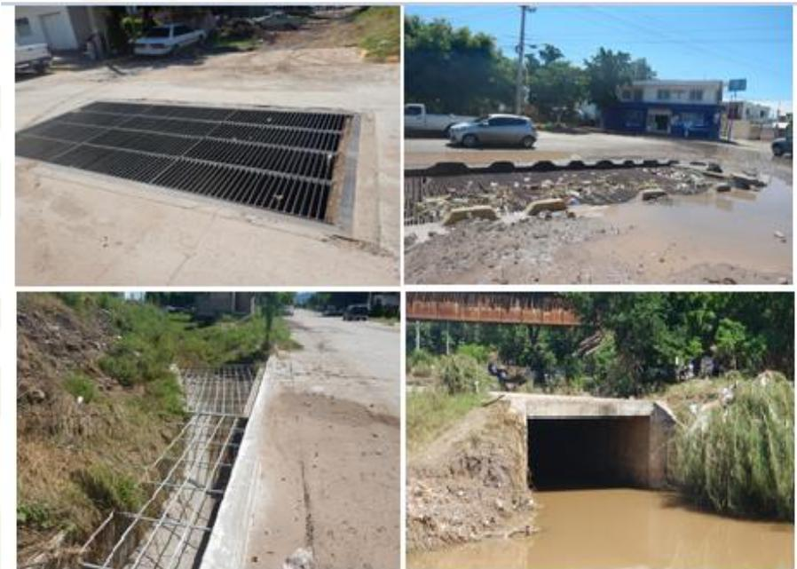
Figura 28. Rejillas pluviales y descarga al río Évora, ciudad de Guamúchil
