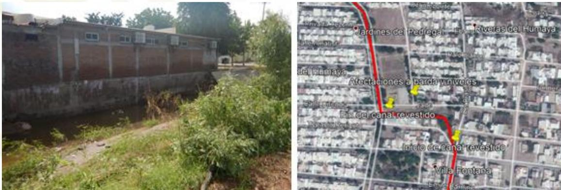
Figura 20. Tramo del canal sin revestimiento y con cambios bruscos de dirección, ubicado en la colonia Villa Fontana, ciudad de Culiacán
