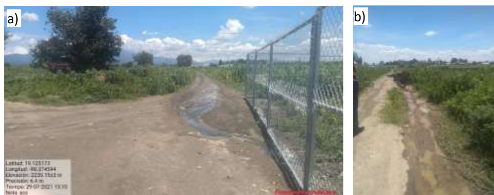
Fig. 4. Camino que funciona como afluente en la sección sureste del socavón
