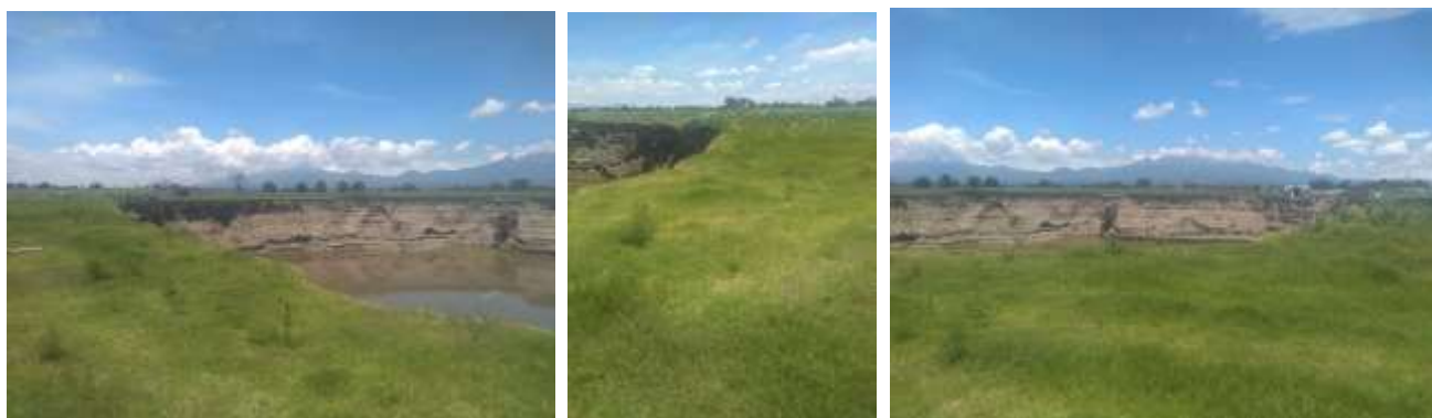
Fig. 2. Inmediaciones del socavón
