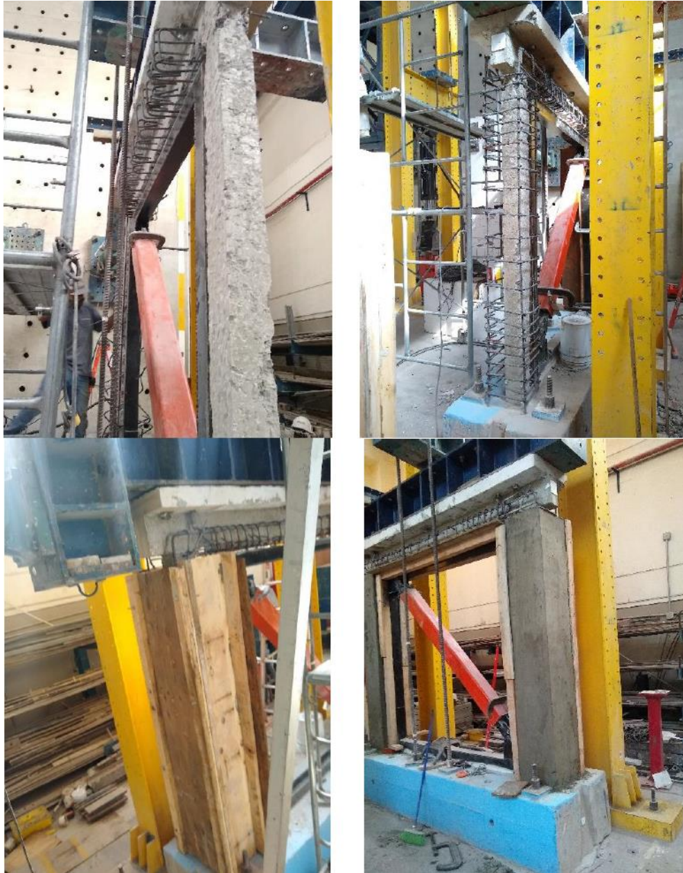
Figura 14. Proceso de refuerzo del marco de concreto y la inserción del contraviento restringido al pandeo
