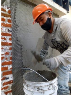
Aplicación de la malla de fibra de vidrio con mortero industrializado
