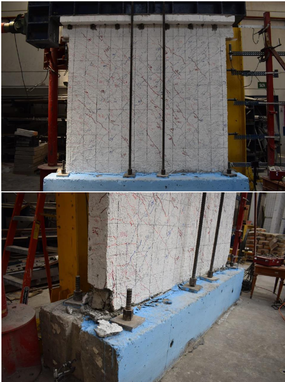
Figura 16.c. Modelo M-3R, patrón de daño a 1.0% de distorsión
