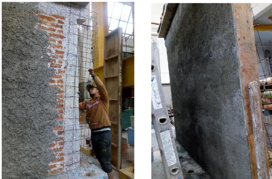
Figura 12. Proceso de refuerzo con fibras en el mortero de repellado
