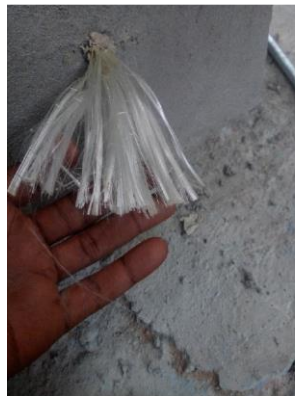
Anclaje del refuerzo de fibra de vidrio en la cara opuesta al refuerzo
