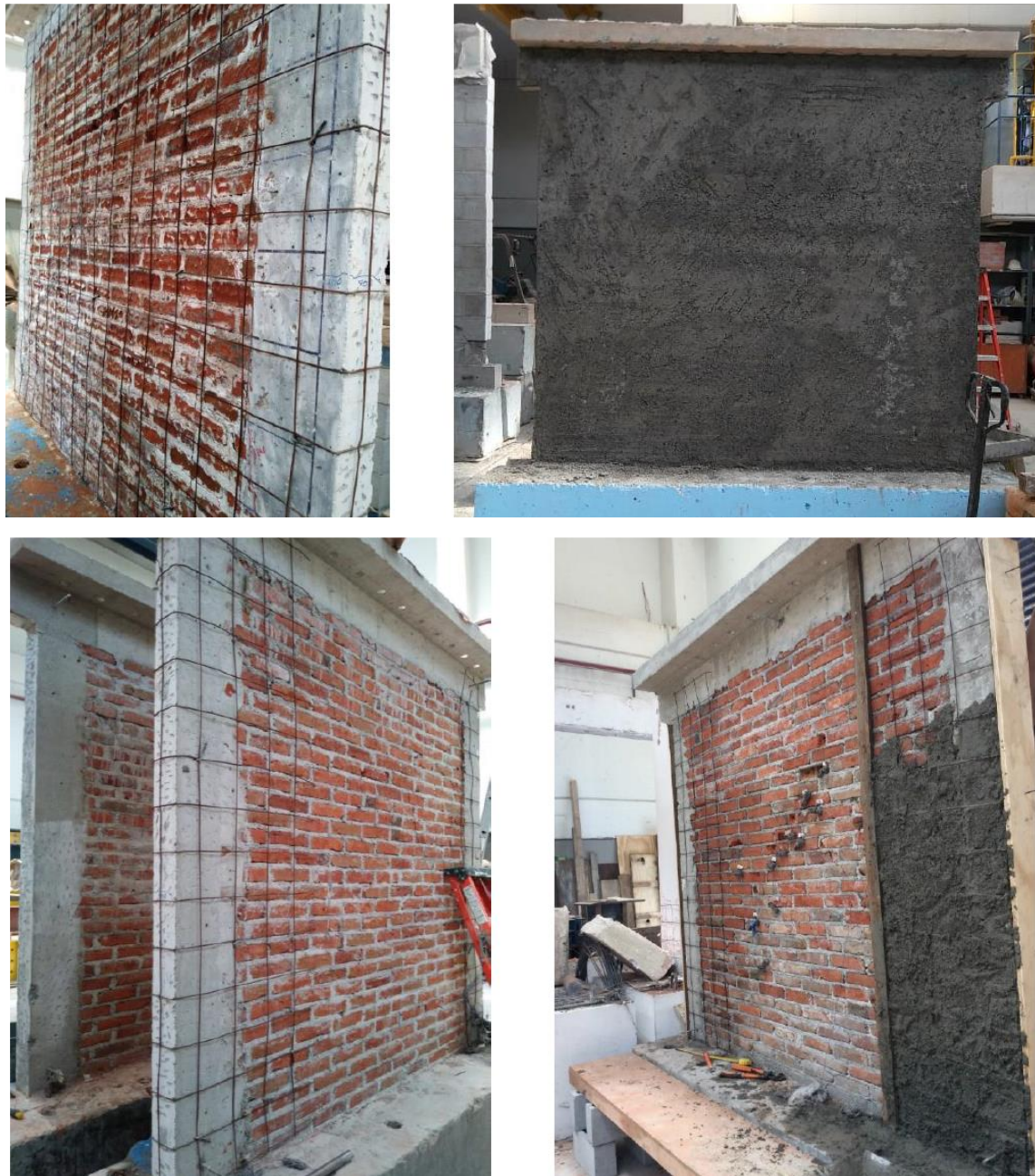
Figura 11. Proceso de refuerzo con malla y mortero
