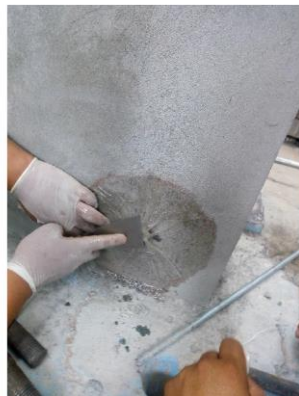
Anclaje del refuerzo de fibra de vidrio en la cara opuesta al refuerzo
