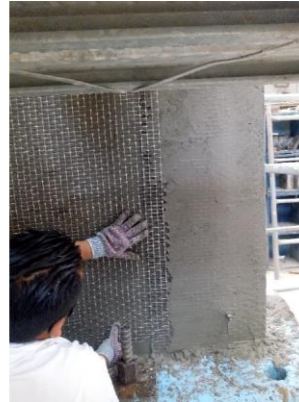
Aplicación de la malla de fibra de vidrio con mortero industrializado
