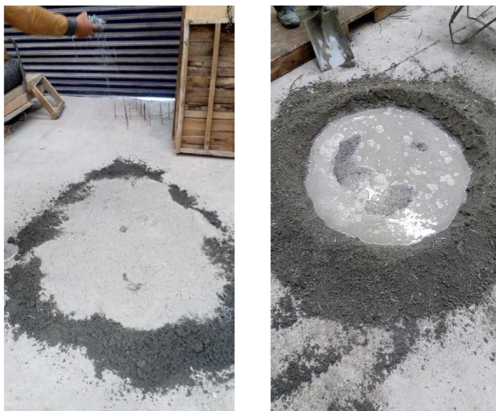
Mezclado del mortero con fibras
