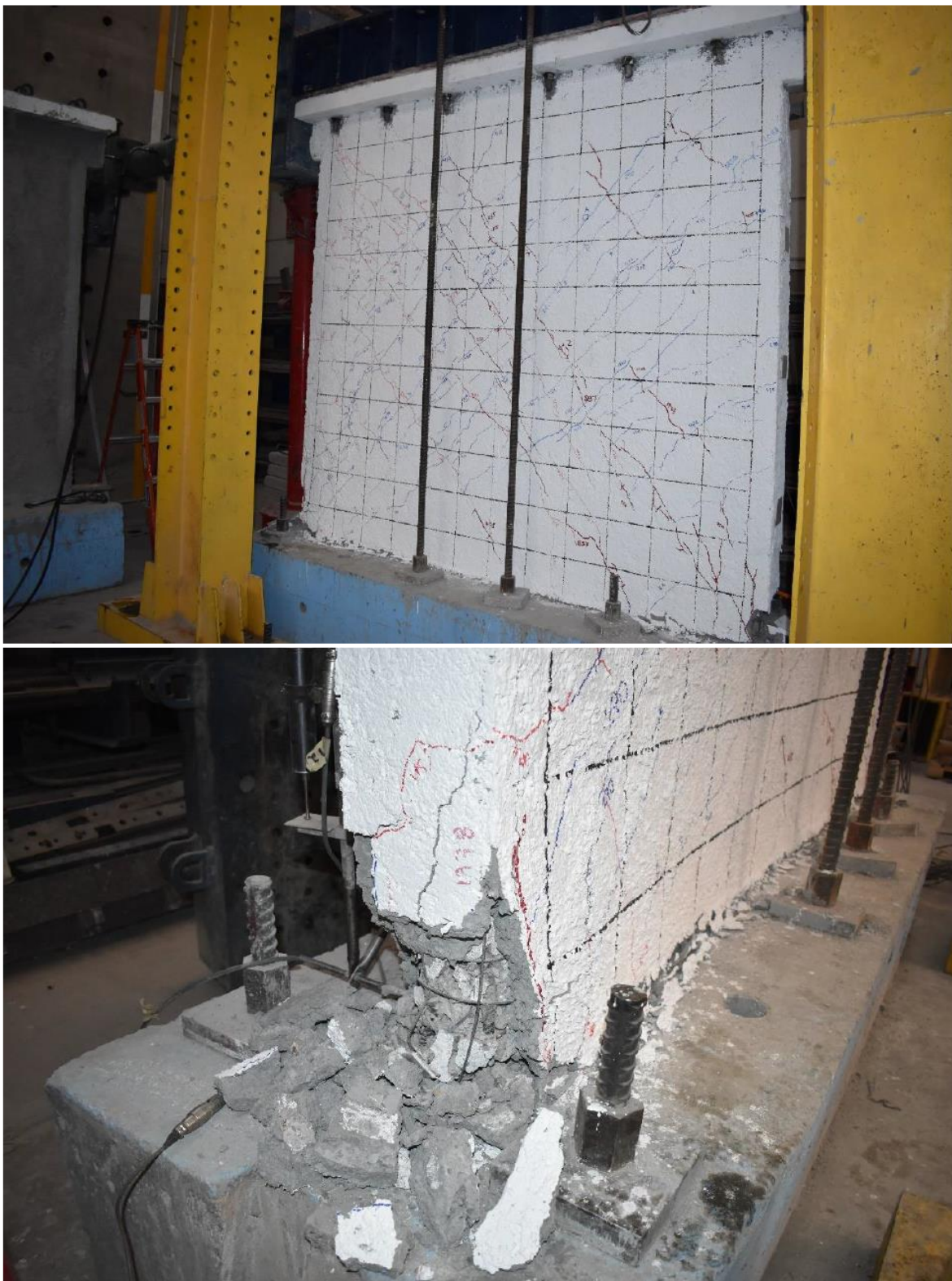
Figura 16.b. Modelo M-1R, patrón de daño a 1.0% de distorsión
