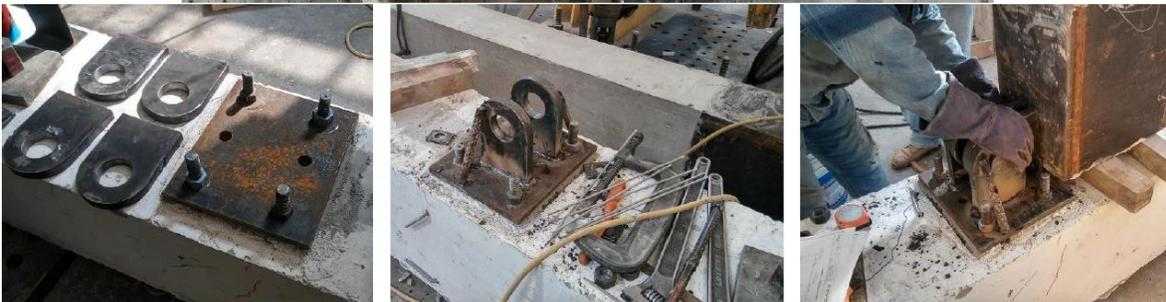
**Figura 5** Fotografías que muestran el proceso de colado del concreto en los elementos, así como la colocación de la rótula
