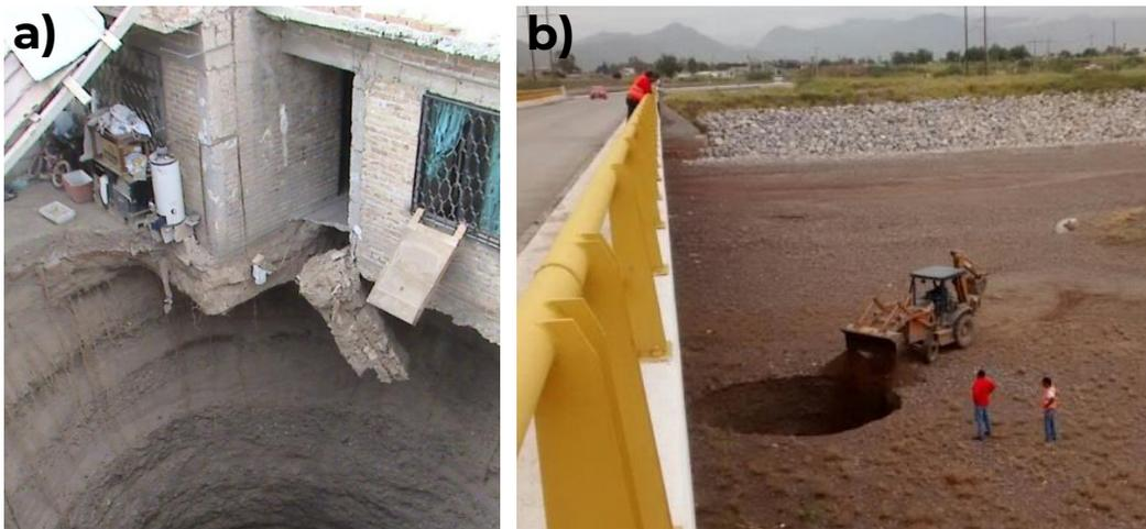
**Figura 10. a) Hundimientos súbitos en la colonia César G. Meraz, municipio de Lerdo, diciembre 2008 y b) Puente la Comarca en el Río Nazas, 28 de septiembre 2016. (<https://www.milenio.com/estados/rellenan-enorme-socavon-lecho-seco-nazas>)**
