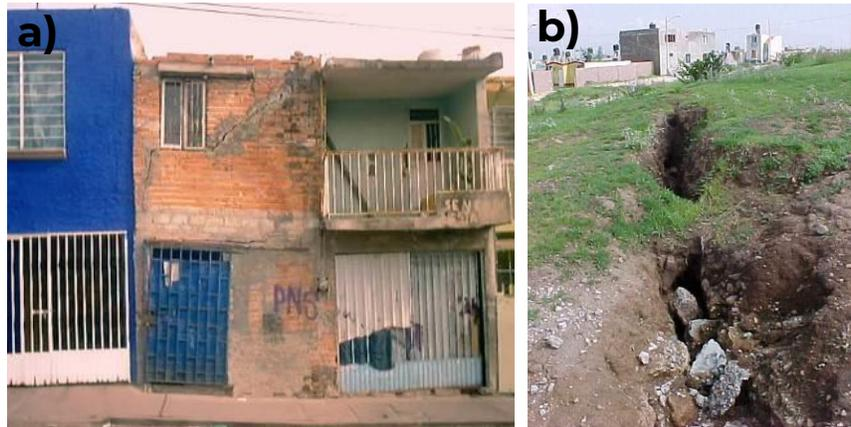
**Figura 16. a) Daños observados en una vivienda del municipio de Aguascalientes, mayo de 2003 y b) Efectos del hundimiento regional estado de México, base de datos CENAPRED**
