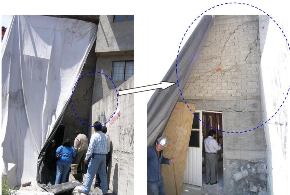
**Figura 14. Viviendas dañadas por estar desplantada sobre una mina, colonia Golondrinas, Álvaro Obregón, base de datos CENAPRED**
