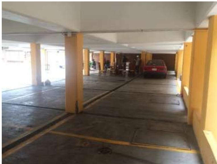
**Figura 1.10** Vista del estacionamiento, donde se observa falta de columnas en dos intersecciones de ejes.
