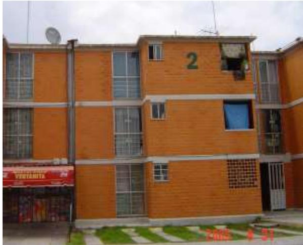
**Figura 3.13** Muros de mampostería con refuerzo interior
