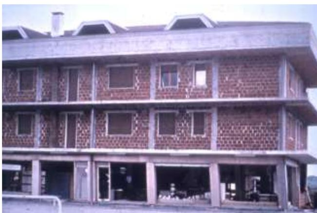
*Figura 3.26 Planta baja flexible*
