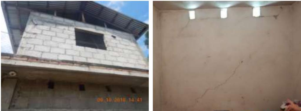
**Figura 3.29** Muros con ventilas en la parte superior
