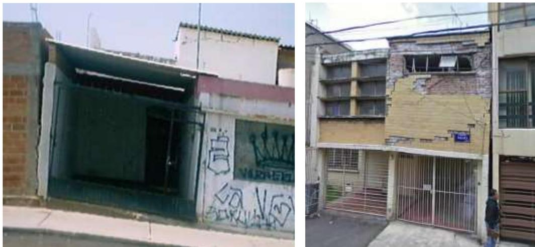
*Figura 3.35 Hundimientos diferenciales*
