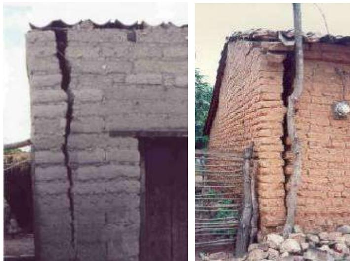
*Figura 0.44 Agrietamiento en uniones de muros*
