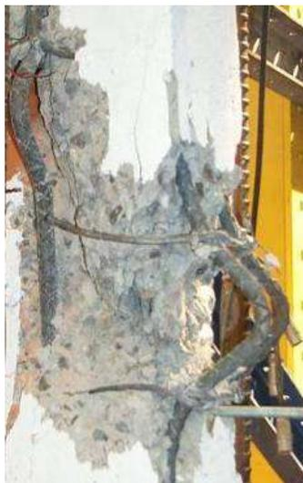
*Figura 0.43 Pandeo del refuerzo longitudinal en castillos*
