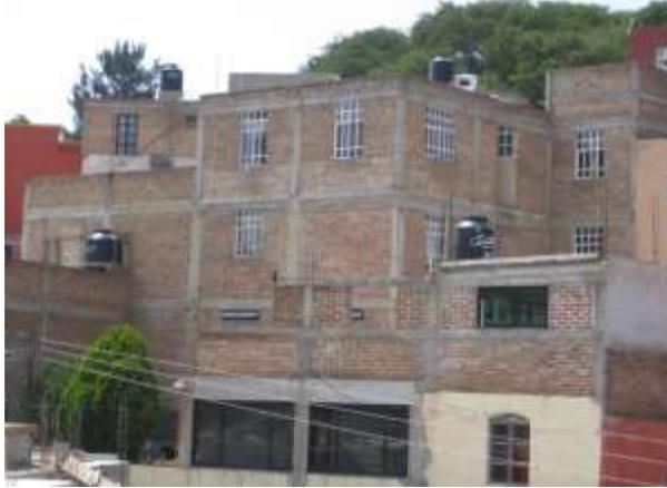
**Figura 3.12** Muros de mampostería deficientemente confinada
