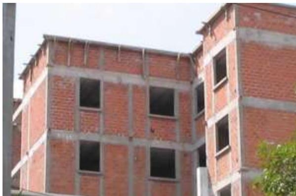
**Figura 3.14** Muros de mampostería adecuadamente confinada
