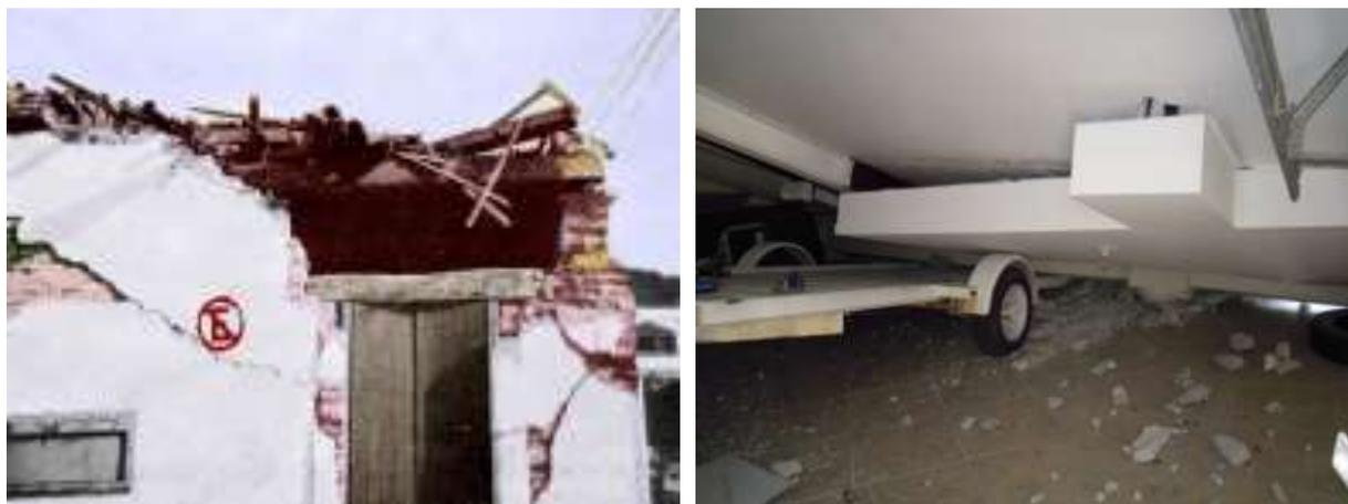
*Figura 0.36 Colapso de techos o losas*
