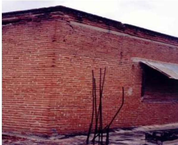
**Figura 3.11 Muros de mampostería simple**
