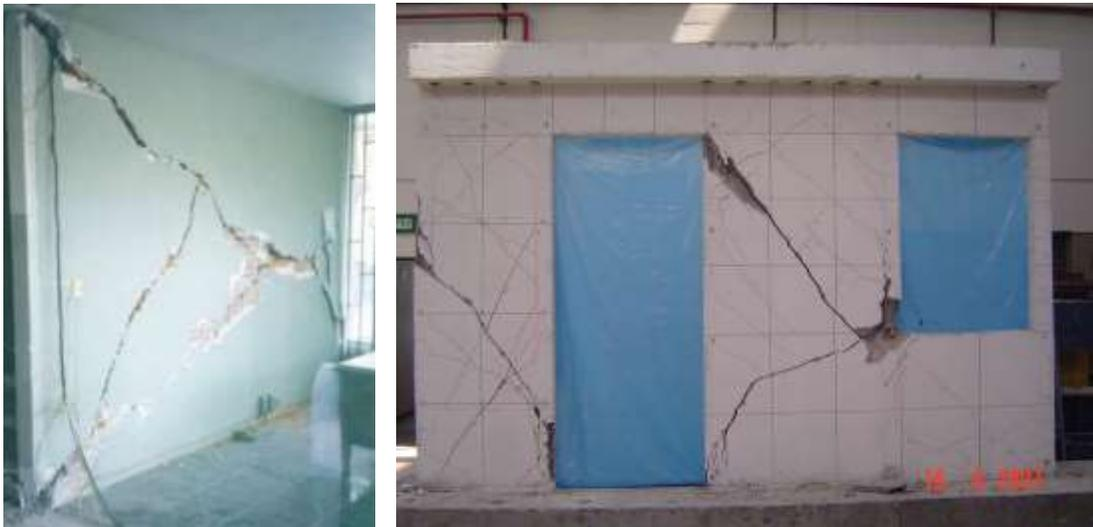
*Figura 0.41 Ejemplos de agrietamiento a cortante*
