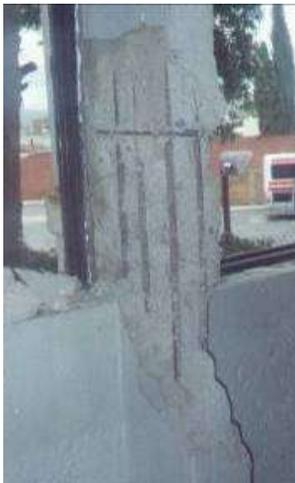
*Figura 0.42 Desprendimiento del concreto y acero de refuerzo expuesto*
