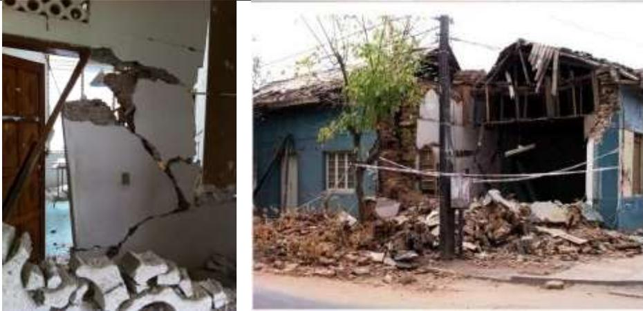
*Figura 0.40 Ejemplos de colapso de muros*
