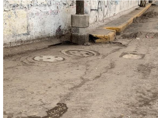
Figura 4.1 Imágenes de caja de coladeras pluviales paralela a av. del Imán y los pozos de visita de la red de drenaje (Fuente: SRI, 2020)
