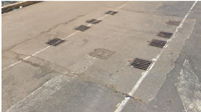
Figura 4.3 Imagen de la caja de coladeras pluviales paralelas al sentido de Av. del Imán y su estado posterior al evento de inundación (Fuente: SRI)
