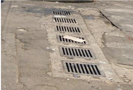
Figura 4.1 Imágenes de caja de coladeras pluviales paralela a av. del Imán y los pozos de visita de la red de drenaje (Fuente: SRI, 2020)
