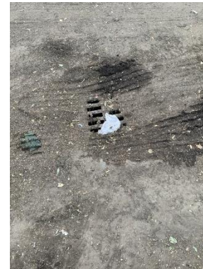
Figura 4.3 Imagen de la caja de coladeras pluviales paralelas al sentido de Av. del Imán y su estado posterior al evento de inundación (Fuente: SRI)
