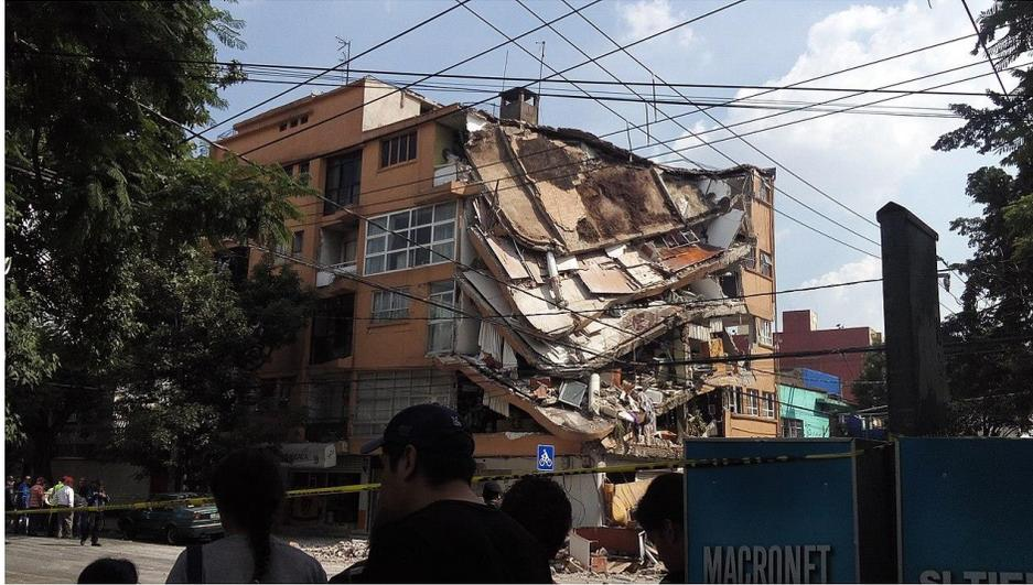
**Figura 5. Vista general de edificio de seis niveles ubicado en esquina que presentó colapso durante el sismo de 2017 (<https://commons.wikimedia.org/w/index.php?curid=62587165>)**
