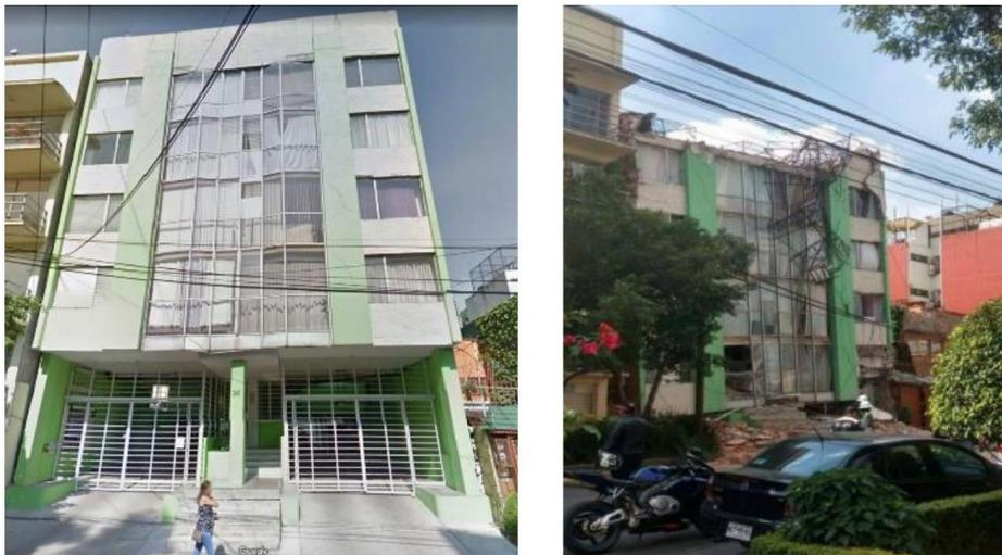
**Figura 3. Vista general de edificio de cinco niveles con colapso por planta baja flexible (Hernández, et al (2019))**
