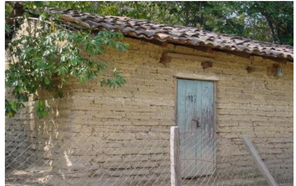
Muros de adobe con techo rígido y flexible
