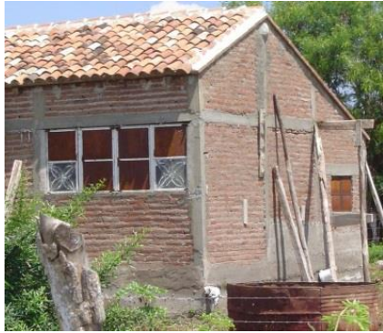
Muros de mampostería con techos flexibles
