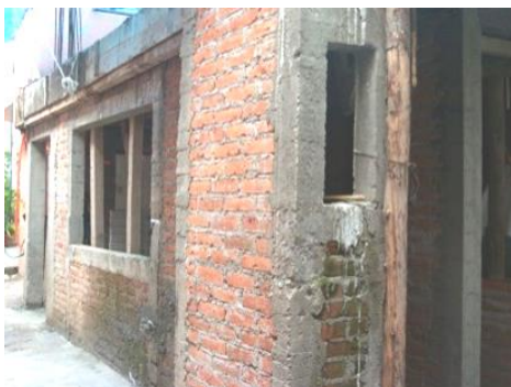
Muros de mampostería con techos rígidos
