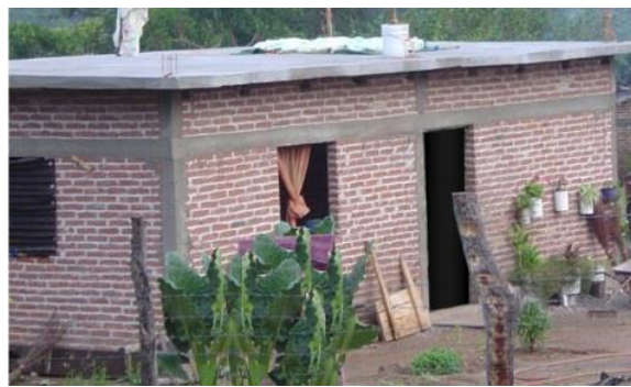
Muros de mampostería con techos rígidos
