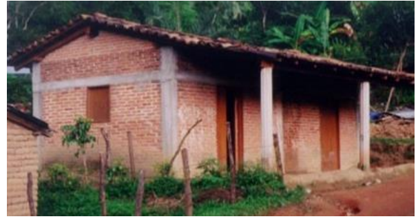
Muros de mampostería con techos flexibles
