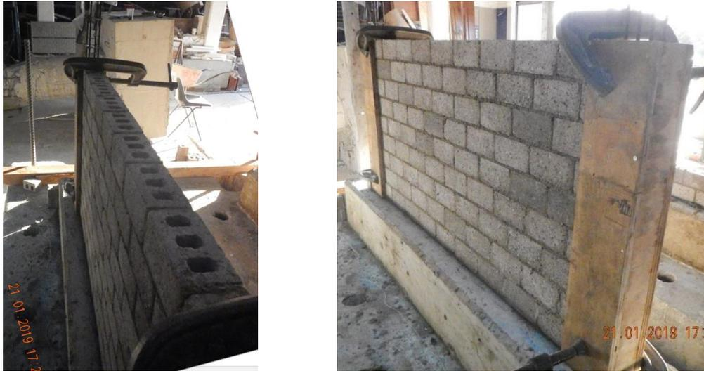
**Figura B.2 Construcción de los muros: a) pegado de tabiques, b) cimbra y colado de castillos**
