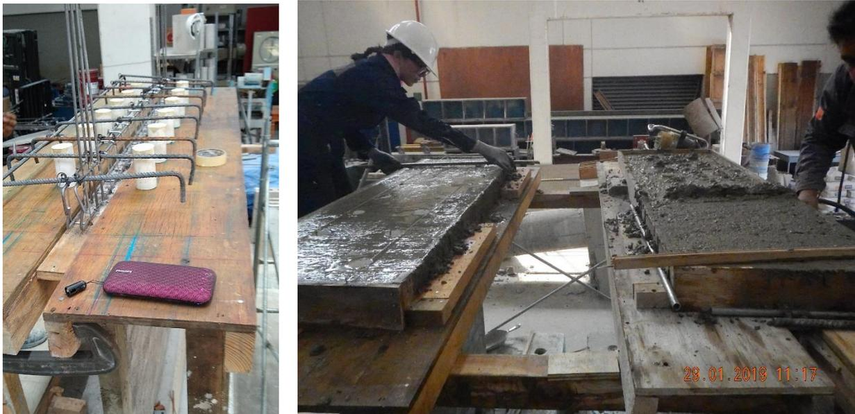
**Figura B.3 Armado, cimbra y colado de las dalas y losas superiores de los muros**
