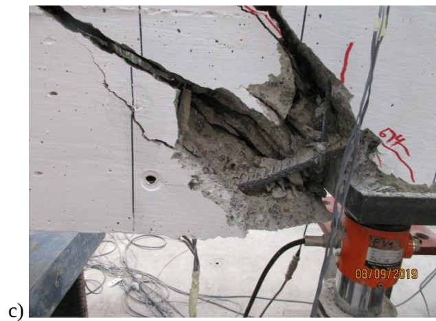
Figura 24 a) Gráfica Deformación Unitaria-Carga VT1, b) Deformímetros B1, B2 y B3 (refuerzo longitudinal en la parte inferior) c) Estado final del refuerzo longitudinal inferior
