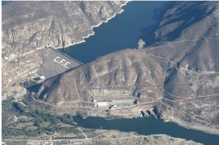
**Figura 6.19.- Vista aérea de la cortina y túneles de desfogue de la presa Infiernillo (Sistema de Seguridad de Presas, 2012)**
