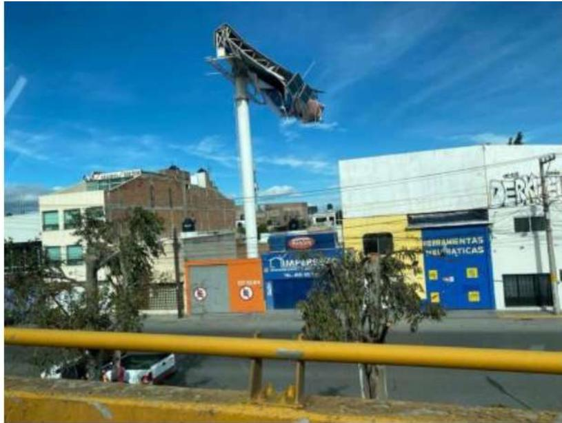
*Figura A1. 86 Espectacular afectado por fuertes vientos*
